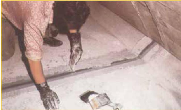
Vand Hypalon Tape ، سیستم درزگیری و آببندی درزها، با کارایی فوق العاده، مخصوص درزهای نامناسب با حرکات شدید که درون آنها واتر استاپ گذاشته نشده یا واتر استاپ موجود پس از بتونریزی کارایی خود را از دست داده است.
